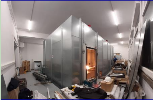
Fig. 1. La cage de Faraday en cours de montage.
